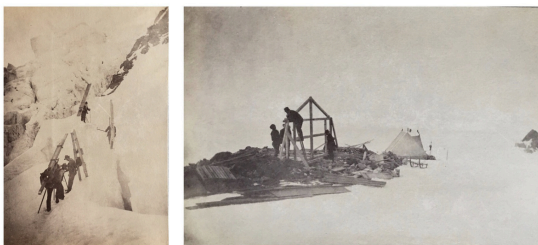
Construction de l'observatoire du Mont-Blanc en 1890. Collection musée alpin, Chamonix-Mont-Blanc.
